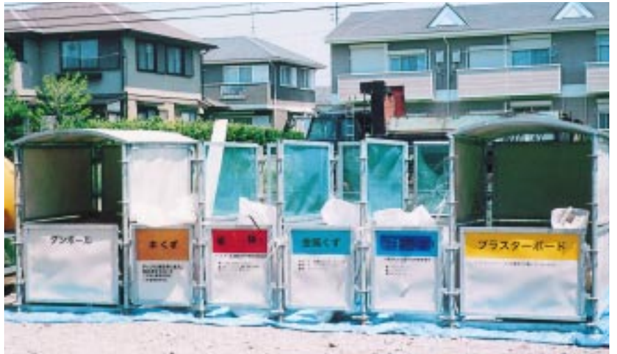
施工現場での分別の様子
