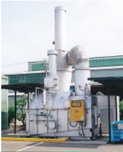
廃止した焼却炉
