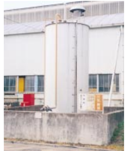
灯油タンク(竜ヶ崎工場)
