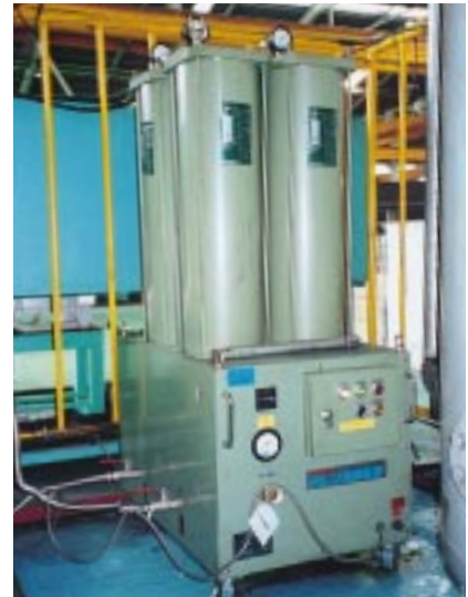
油水分離機(三重工場)
