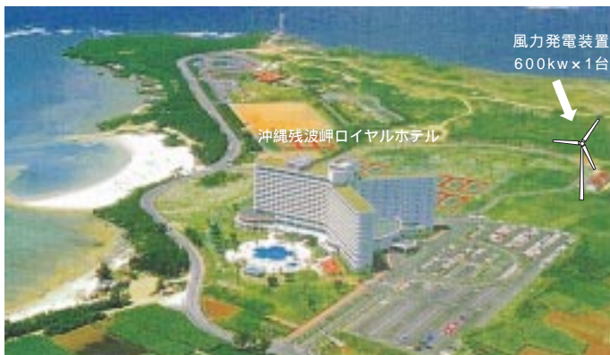
風力発電装置の設置予定場所
