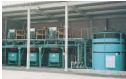
電着排水処理施設(三重工場)
