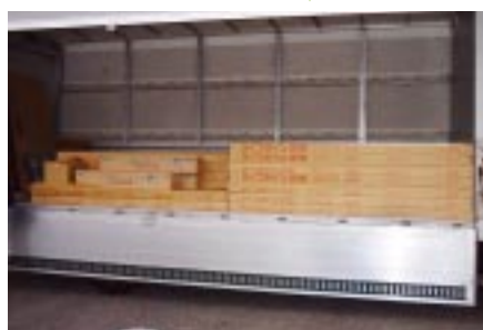
トラックに積み込みリサイクル施設へ運搬
