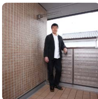
腰壁はリサイクル材を使用。保水性のある床材は打ち水効果も。
