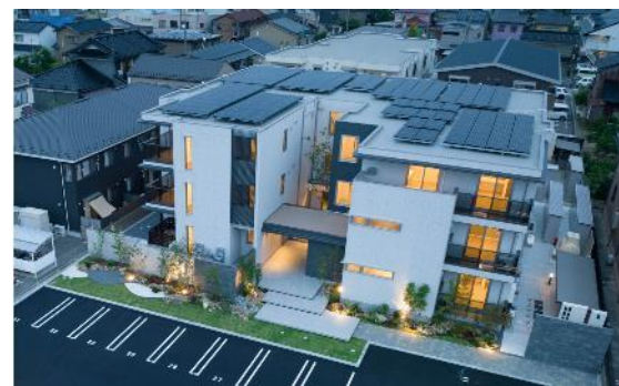
ZEH-M施工事例 (石川県金沢市)
