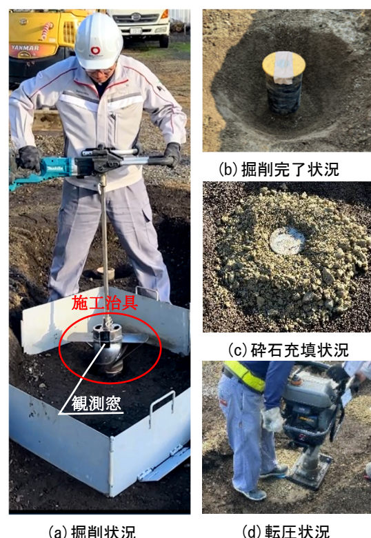
写真 1 砕石部施工状況例
