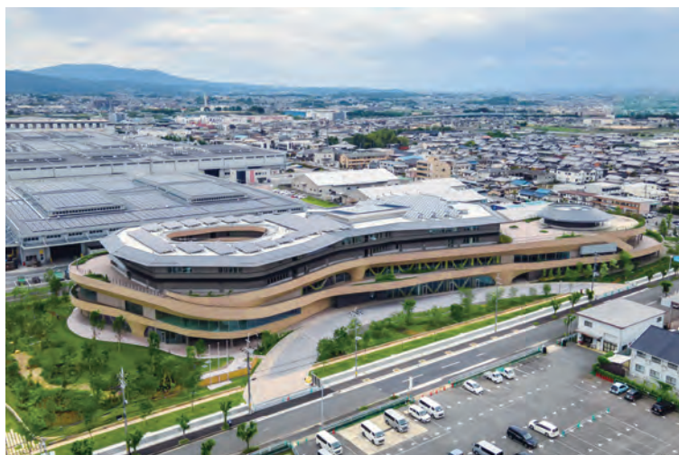
大和ハウスグループの研修施設「みらい価値共創センター」(奈良県)
