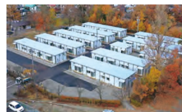
応急仮設住宅
