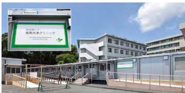
奈良県西和医療センター 発熱外来クリニック外観
