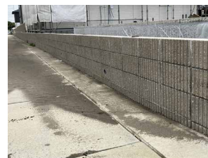
【水害対策】 水路境界の嵩上げ
