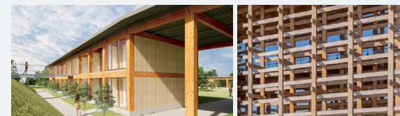
木造の復興公営住宅試験ハウス（石川県珠洲市） 大屋根リングの柱・梁 ➡ Future with Wood（建築物の木造・木質化）
