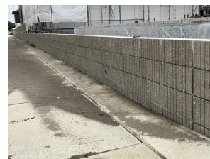
【水害対策】 水路境界の嵩上げ
