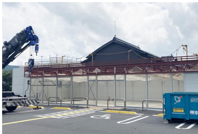
解体の様子(岡山県内の閉店店舗)
