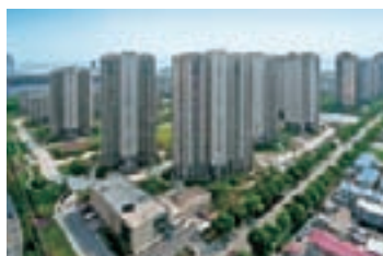
グレース・レジデンス（和風雅致）／蘇州 竣工 2011年（予定） 開発事業体 大和房屋（蘇州）房地產開發有限公司 ※ 大和ハウス工業 100%出資 用途 分譲マンション 販売戸数 902戸
