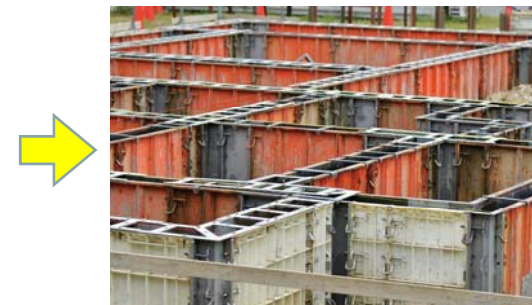
コンクリート打設前
