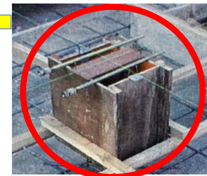
コンクリート打設前
