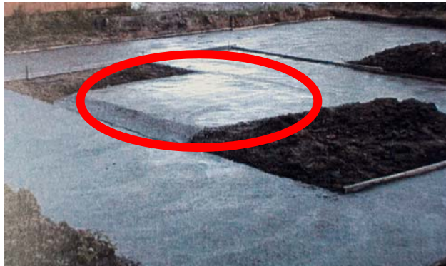
コンクリート打設
