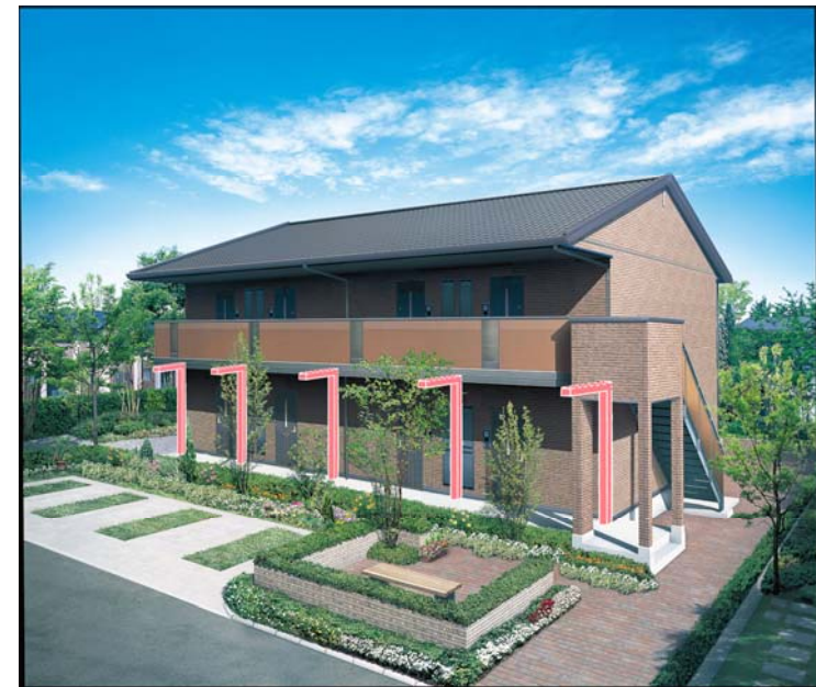
赤い柱部分が不適合施工
