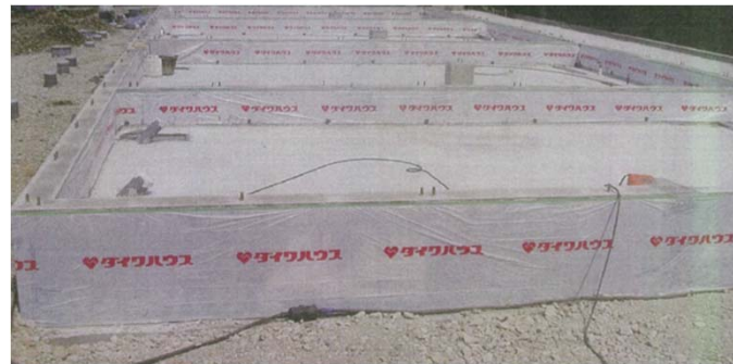
コンクリート打設後、基礎検査
