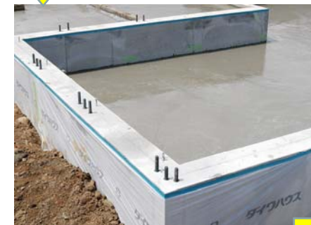
コンクリート打設後
