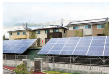
スマ・エコタウン 陽だまりの丘 日本初、街の太陽光発電所の 収益を住宅のメンテナンス に活用。
