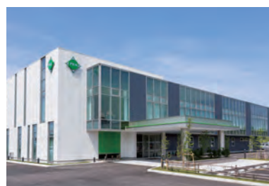
P・Fオートメーション 株式会社 新社屋 自社施設で培ったノウハウを 活用し、ネット・ゼロ・エネ ルギー・ビル(ZEB)を実現。
