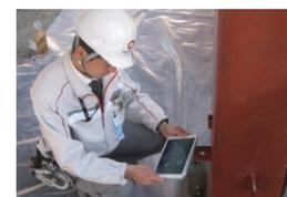
タブレット端末を用いて検査結果を現場で入力
