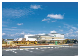
体育館(大和リース)
