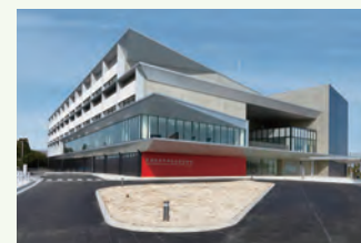
運転免許試験場(大和リース)
