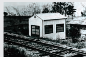
1955 パイプハウス 鋼管(パイプ)建築の考案により、戦後の木材・資材不足の解決に貢献
