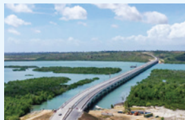
子会社フジタによるケニアモンバサ港周辺道路開発プロジェクト
