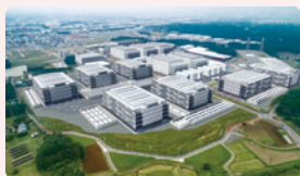
データセンター
