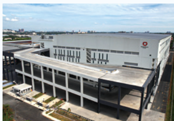
DPL マレーシア シャーアラムIII (外観)
