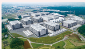
データセンター
