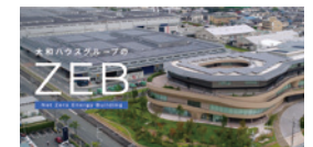
ZEB 施工事例の紹介
