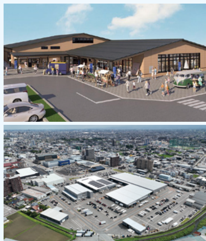
富山市の地方卸売市場「D-Ichiba」は、老朽化した公設地方卸売市場の建て替えと余剰地活用を行う日本初の官民連携（PPP）事業
