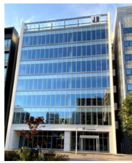
オフィスビル『d_II』 (三重県四日市市)
