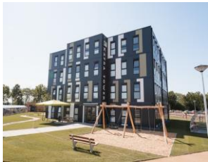
避難民向け住宅
