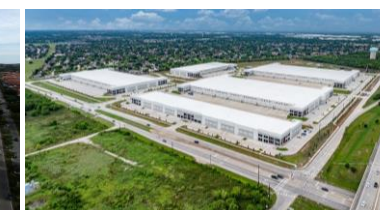
米国・テキサス州 Blue Ridge Commerce Center (5棟、延床面積約12万5千㎡)
