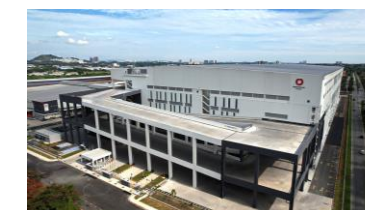
マレーシア・セランゴール州 DPL Malaysia Shah Alam III (延床面積約15万6千㎡)
