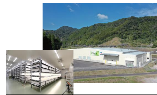
事業施設コンバージョン 植物工場システム
