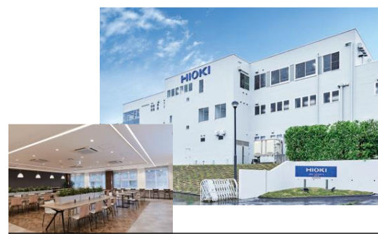
Dプロジェクト リブネス上田 半導体関連工場
