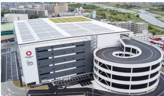
太陽光発電システム
