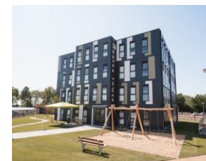
避難民向け住宅
