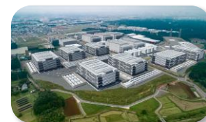
データセンター
