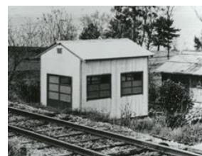
パイプハウス
