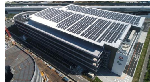
屋根上太陽光パネル (物流施設)
