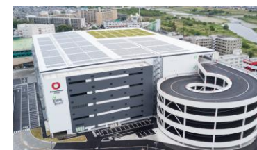
太陽光発電システム
