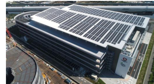
屋根上太陽光パネル (物流施設)
