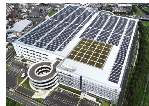
2022年度に開発・稼働した 「DREAM Solar 横浜戸塚」 （神奈川県） （物流施設：DPL 横浜戸塚）
