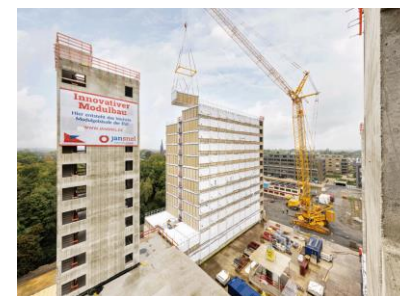
DHME施工現場
