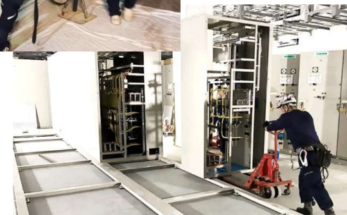
東京国際空港 第2ターミナル 国際線施設建築工事プロジェクト
