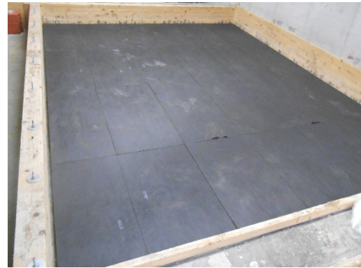
写真1 制振材施工状況
