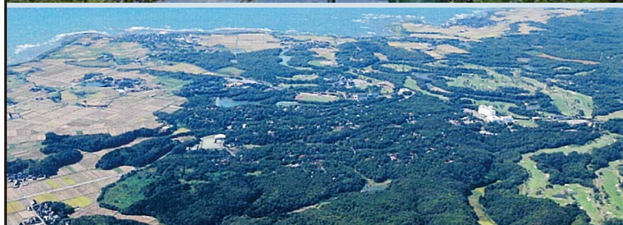
大和ハウス工業が開発したリゾート地
