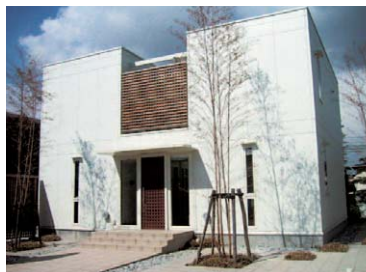
光触媒コーティングから約3年を経過しても白さを保つ検証棟
