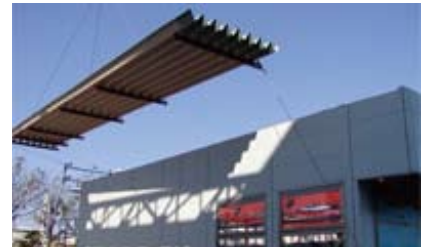
環境対応型店舗(施工中)
