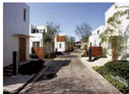
保水性舗装を採用した道路
