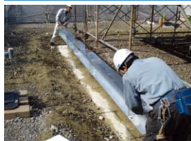
・土台基礎設置
