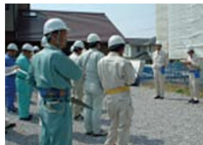
現場担当者による説明を受けその後 作業状況の安全確認を行います。
