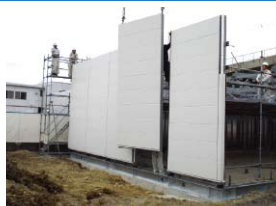
・外壁パネル建方
