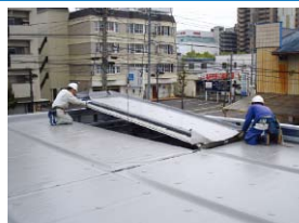
・屋根パネル建方
