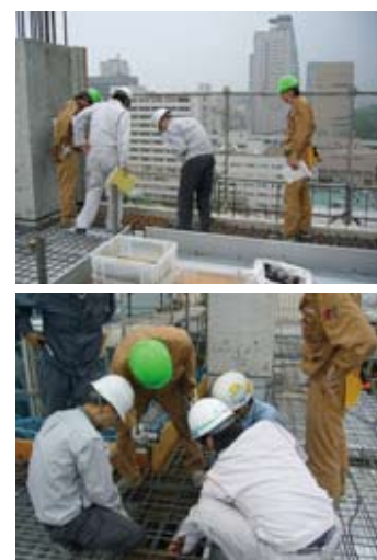
施工状況を確認している様子
