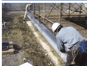
・土台基礎設置
