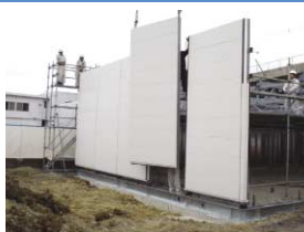
・外壁パネル建方
