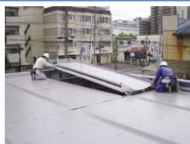
・屋根パネル建方
