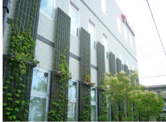
西側外壁面の壁面緑化システム
