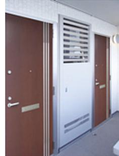
エコキュートの設置スペースに設けた、空気を取り入れに配慮した専用ドア。
