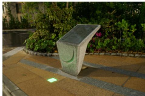
災害時に電力供給が止まった時でも点灯するLEDソーラーライト
