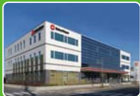
太陽光発電システムや壁面緑化を導入した大和ハウス工業 四日市支店（三重県）
