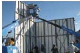
「施工主任技能者検定」実技検定を事業所ごとに実施
