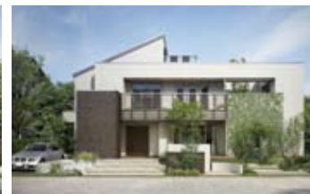
SMA × Eco HOUSE 八事展示場（愛知県）
