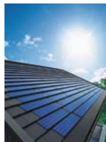
太陽光発電システム
