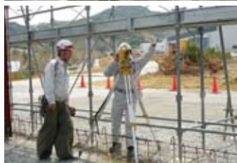
施工店自主検査の様子
