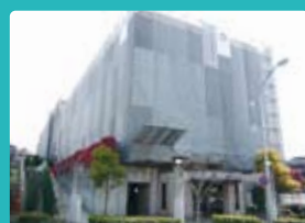
資産価値維持のために、全面外壁補強を実施
