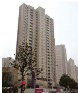
一林立18栋住宅楼的工程现场
