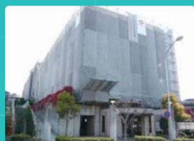
为了维持高资产价值，进行外壁全部的加固
