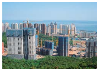
工程现场全景
