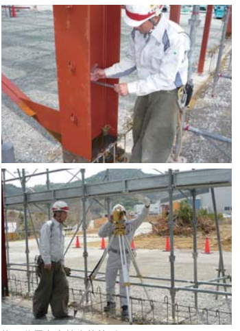
施工公司自主检查的情形
