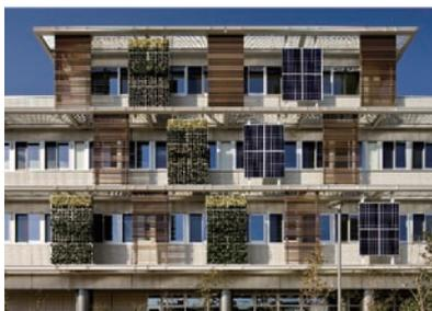
大和ハウス岐阜ビルに設置したD'sフレーム
