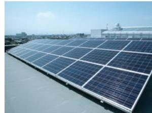
屋上に設置した太陽光発電パネル（11.55kW）
