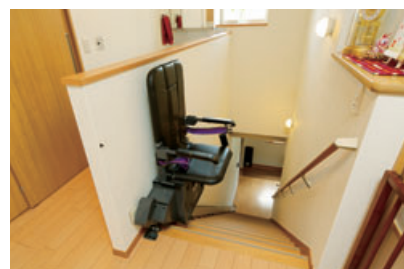
階段に設置した昇降機
