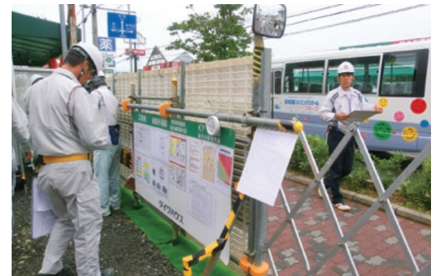
現場内の安全状態を点検
