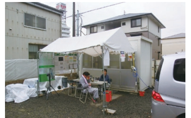
熱中症対策の休憩場所を設置
