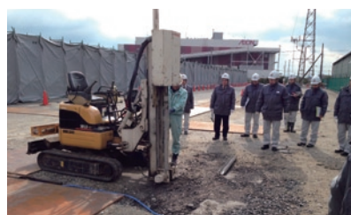
ボーリングによる深度調査の様子(奈良工場)
