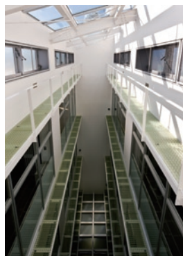
吹き抜け空間「エコボイド」
