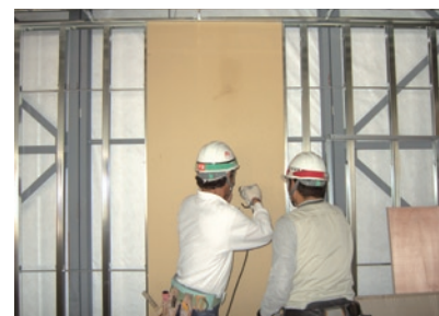
石膏ボードのプレカット施工
