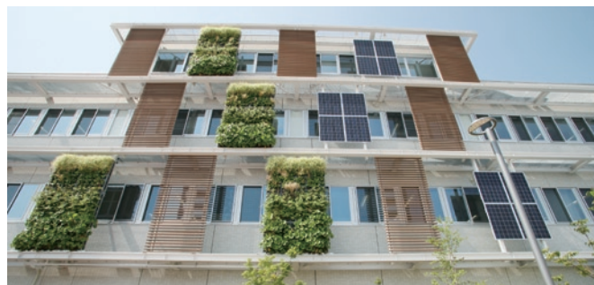
「大和ハウス岐阜ビル」南面に設置されたD's フレーム
