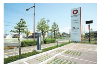
駐車場の緑化と電気自動車の充電スタンド
