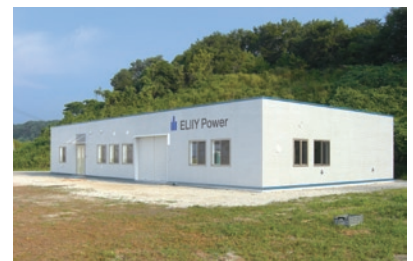
移設・再建築された「エリーパワー技術開発センター甲賀分室」(滋賀県)
