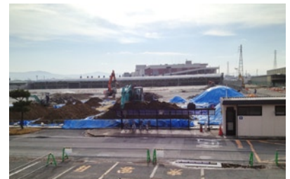
汚染土壌の掘削除去の様子(奈良工場)
