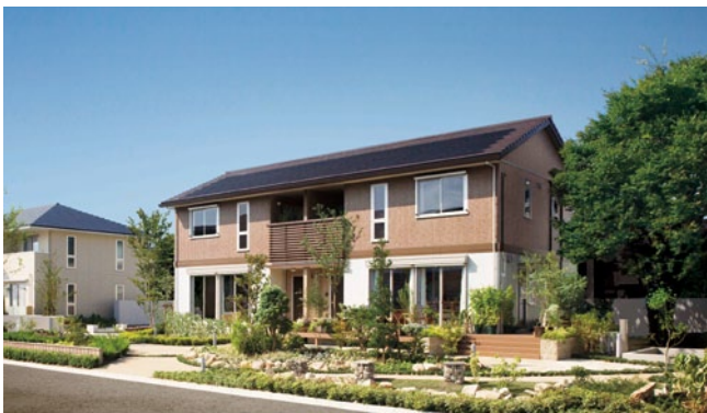
太陽光発電設備を設置した賃貸住宅
