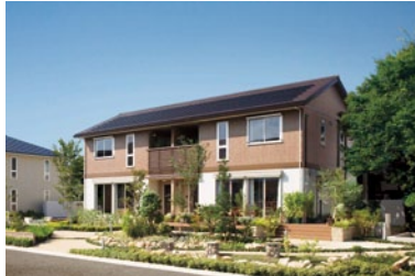
太陽光発電設備を設置した賃貸住宅
