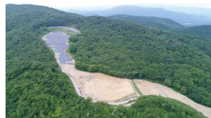
未利用キャンプ跡地へ太陽光発電システムを施工する様子
