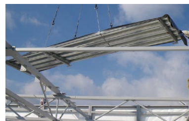
屋根パネルの施工の様子
