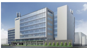
河西工業株式会社 技術新棟
