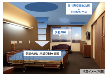
放射冷暖房システム イメージ図(夏)
