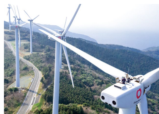
佐田岬風力発電所
