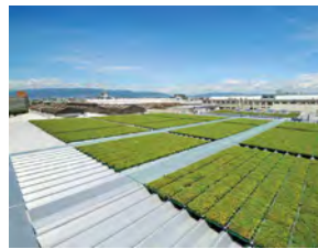
「ecoヤネ」施工例
