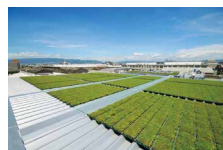
「eco ヤネ」施工例
