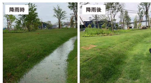
当施設の敷地内のレインガーデン。土壌の浸透率が高く、2021年の大雨の後でも5時間後には雨水の浸透が完了しました。
