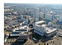
「マールク新さっぽろ」 (I街区) 撮影:大成建設株式会社 2023年10月撮影
