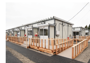
アプローチにはスロープを設置
