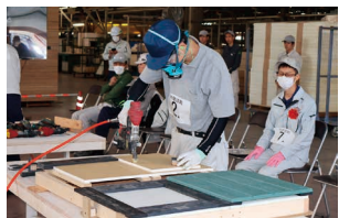
全国工場技能競技会 外壁技能
